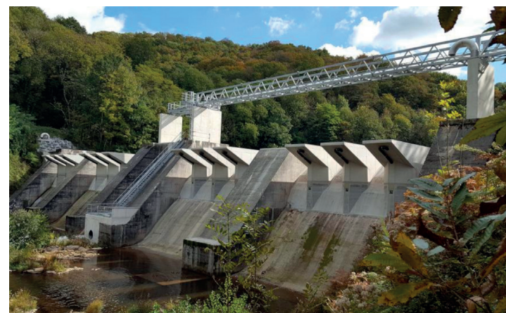
Un barrage après renforcement. © Grégory Coubard
