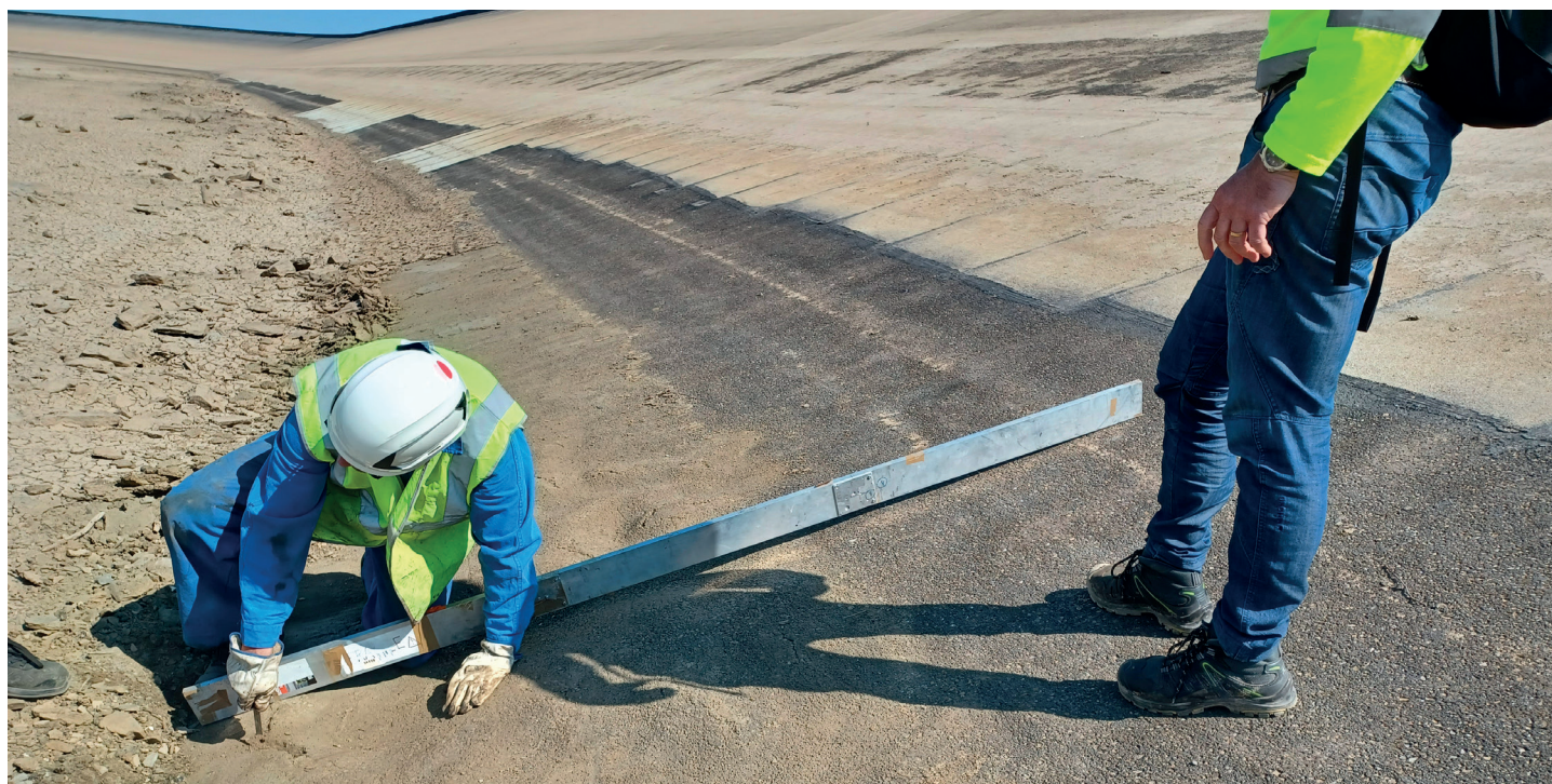
Inspection visuelle du barrage. © Univ. Eiffel
